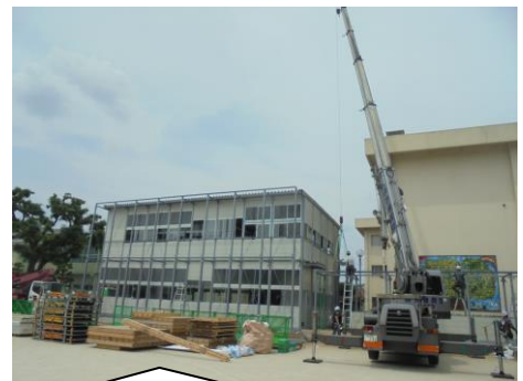
数日で外観ができました。危険な工事は子どもたちが来る前に終了してよかったです。
