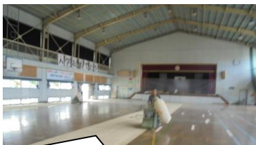
体育館は床の研磨作業にはいいりました。こんなに板の色が違います。新学期はピカピカですよ。
