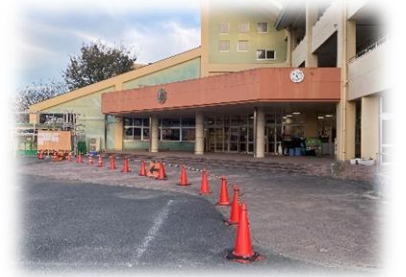
昇降口の前の歩車分離のためのコーン
