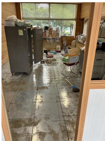
洗浄や配線引直し(事務室)
