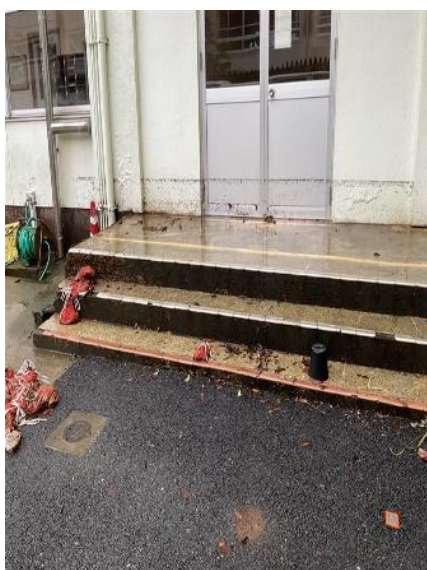
管理棟(中庭出入口)
