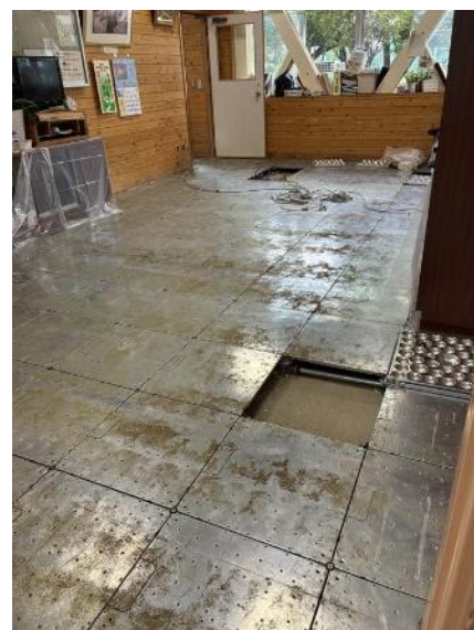
洗浄や配線引直し(校長室)
