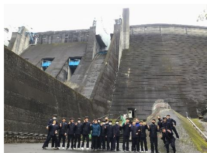
発電所近くから見たダムの様子
