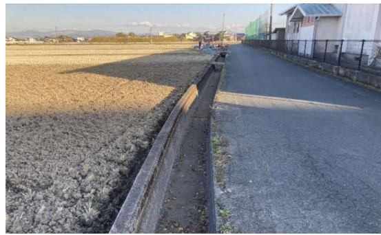
②敷地北側道路及び側溝
