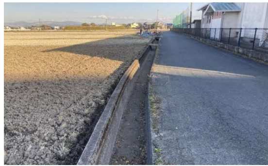
②敷地北側道路及び側溝
