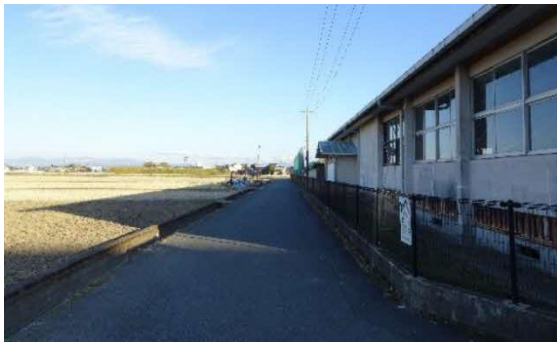
①敷地北側道路
