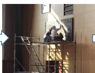
〔2月15日改修作業〕
